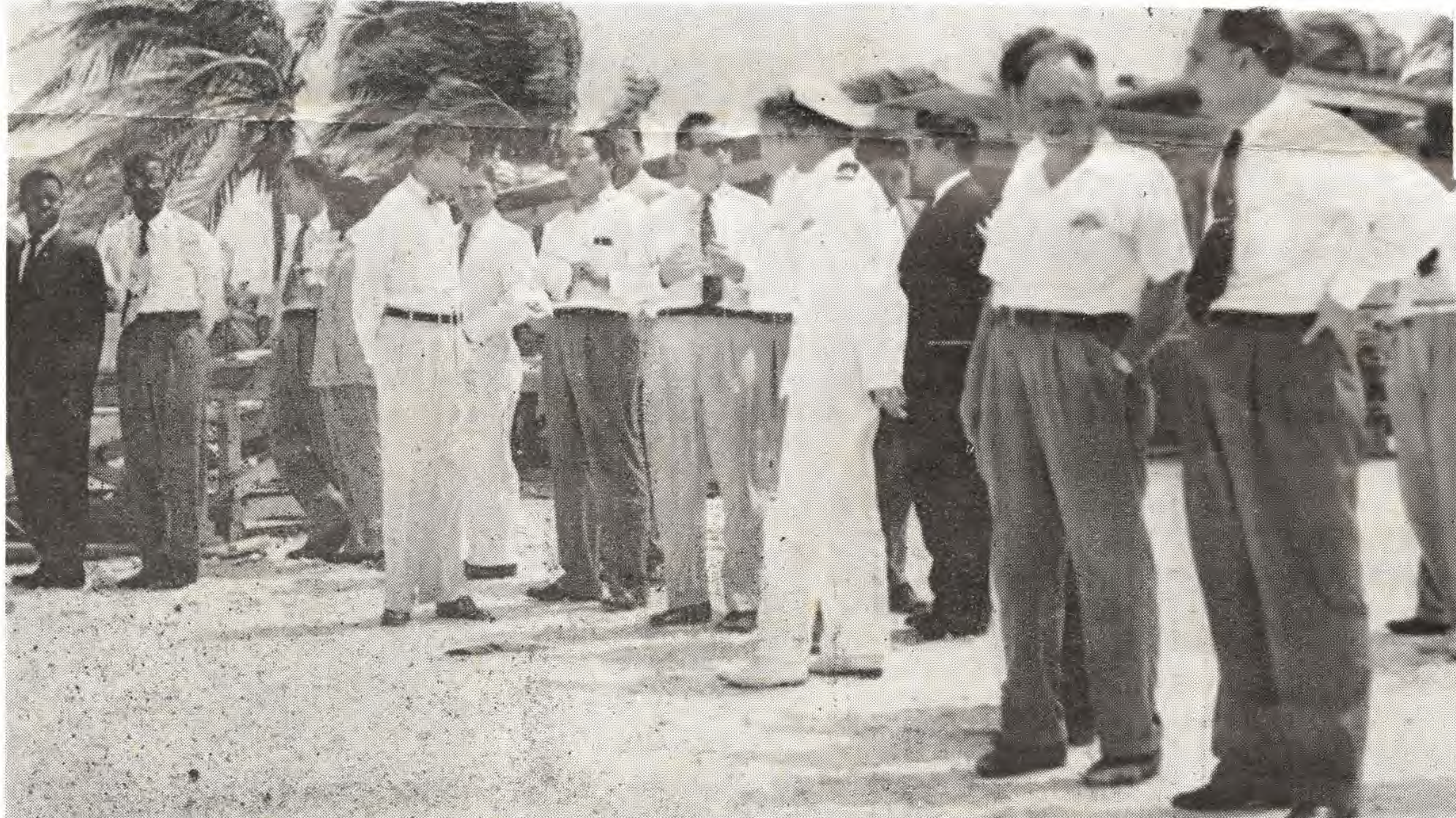
Op bezoek bij de fundering van het Aruba Caribbean Hotel. Rechts op de voorgrond de uitvoerder de heer P. van Dijk met Gedeputeerde P. Croes.
